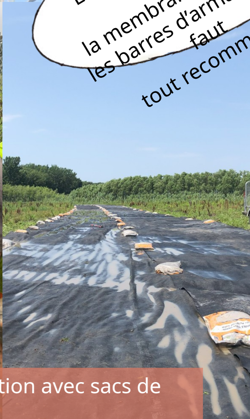
Enfoncement du géotextile
